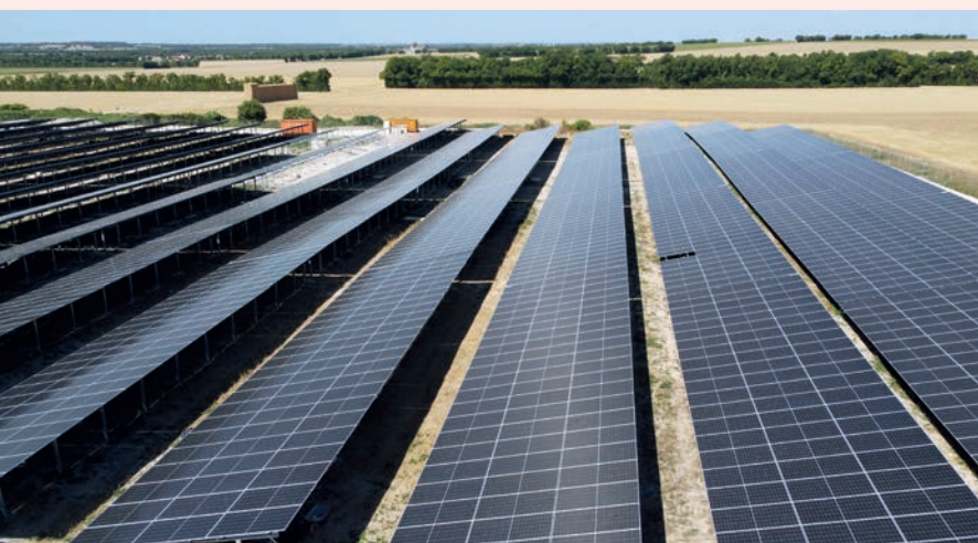
► Parc photovoltaïque de Saint-Mard, © WPD
