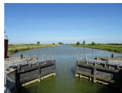
Les écluses du Brault à Charron (Source : PLUi Aunis Atlantique)
