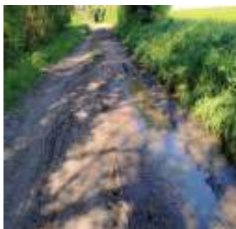
Chemin boueux inexploitable pour les cyclistes
