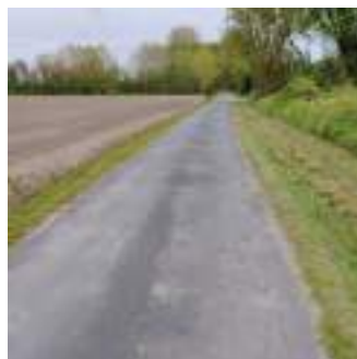
Route secondaire en bon état
