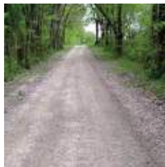
Chemin relativement lisse utilisable sans nécessiter de travaux
