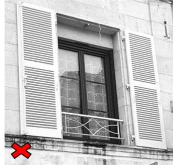
*Adjonction de volets roulants en surépaisseur et changement de menuiseries non adapté.*
