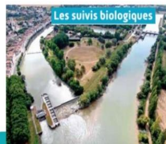
Passe multipiscifique, seuil et clapet sur le bras original (à gauche) et Clôture et barrage sur le bras de dérivation (à droite). ©Damien Filloux - MIGADO
