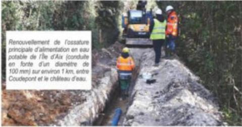
Renouvellement de l'ossature principale d'alimentation en eau potable de l'île d'Aix (conduite en fonte d'un diamètre de 100 mm) sur environ 1 km, entre Coudeport et le château d'eau.
