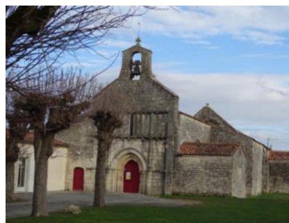
Mur clocher de l'église de Forges
