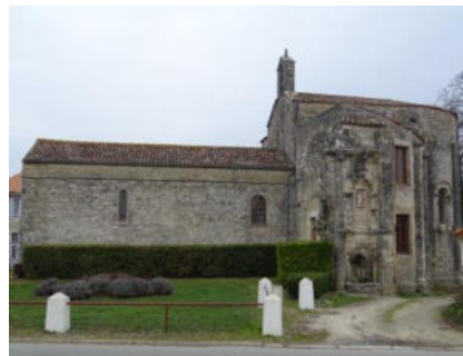
Eglise Saint-Laurent de Bouhet
