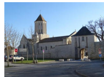
Eglise de Surgères et ses abords
