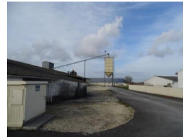
Silo à Breuil-la-Réorte (Source Even Conseil)
