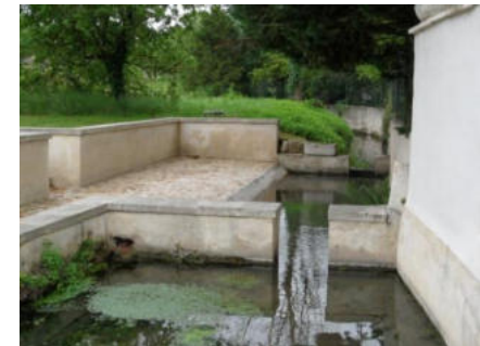
Lavoir St-Saturnin-du-Bois (Crédit photo Nad2000)
