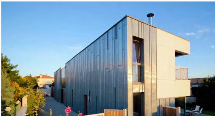
**Bardage** : Tout revêtement de façade mis en place par fixation mécanique sur une ossature.
