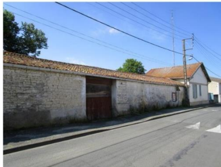
Façade urbaine sur la rue Ronsard
